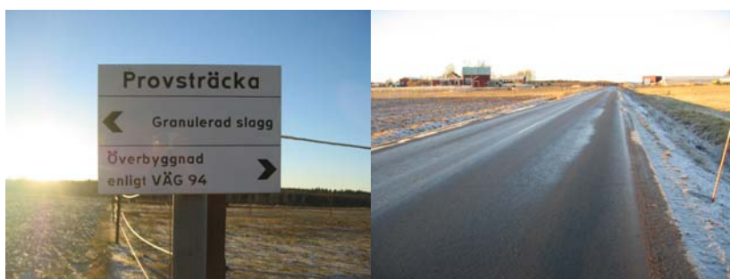
Bild 3.3 Provsträcka 1 med järnsand.
