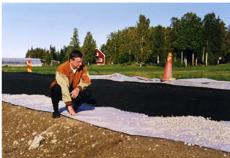
Bild 3.2 Utläggning av järnsand.
