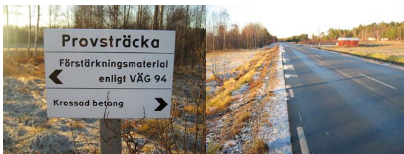
Bild 3.7 Provsträcka 3 med krossad betong.
