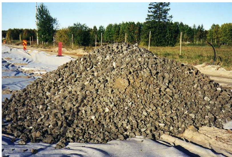
Bild 3.6 Krossad betong färdig för utläggning.
