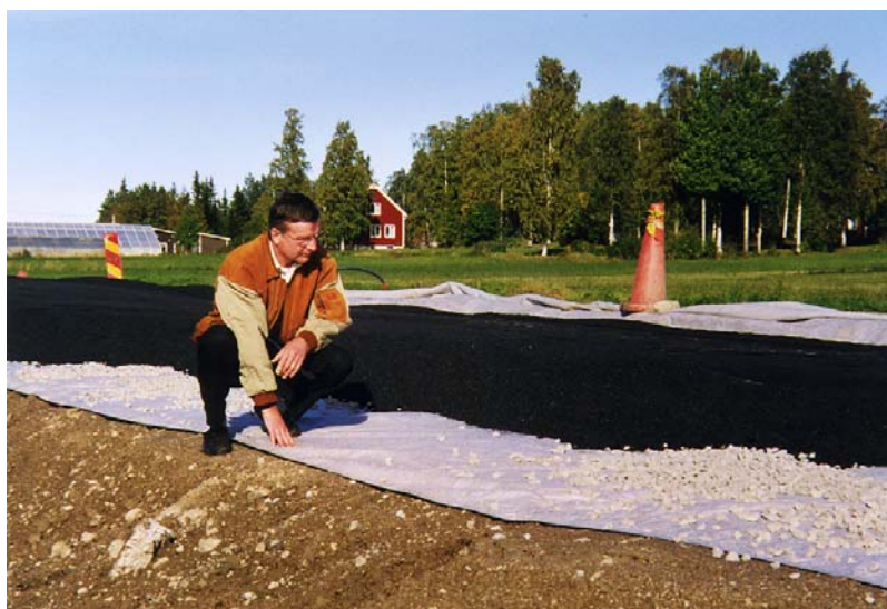
Bild 3.2 Utläggning av järnsand.
